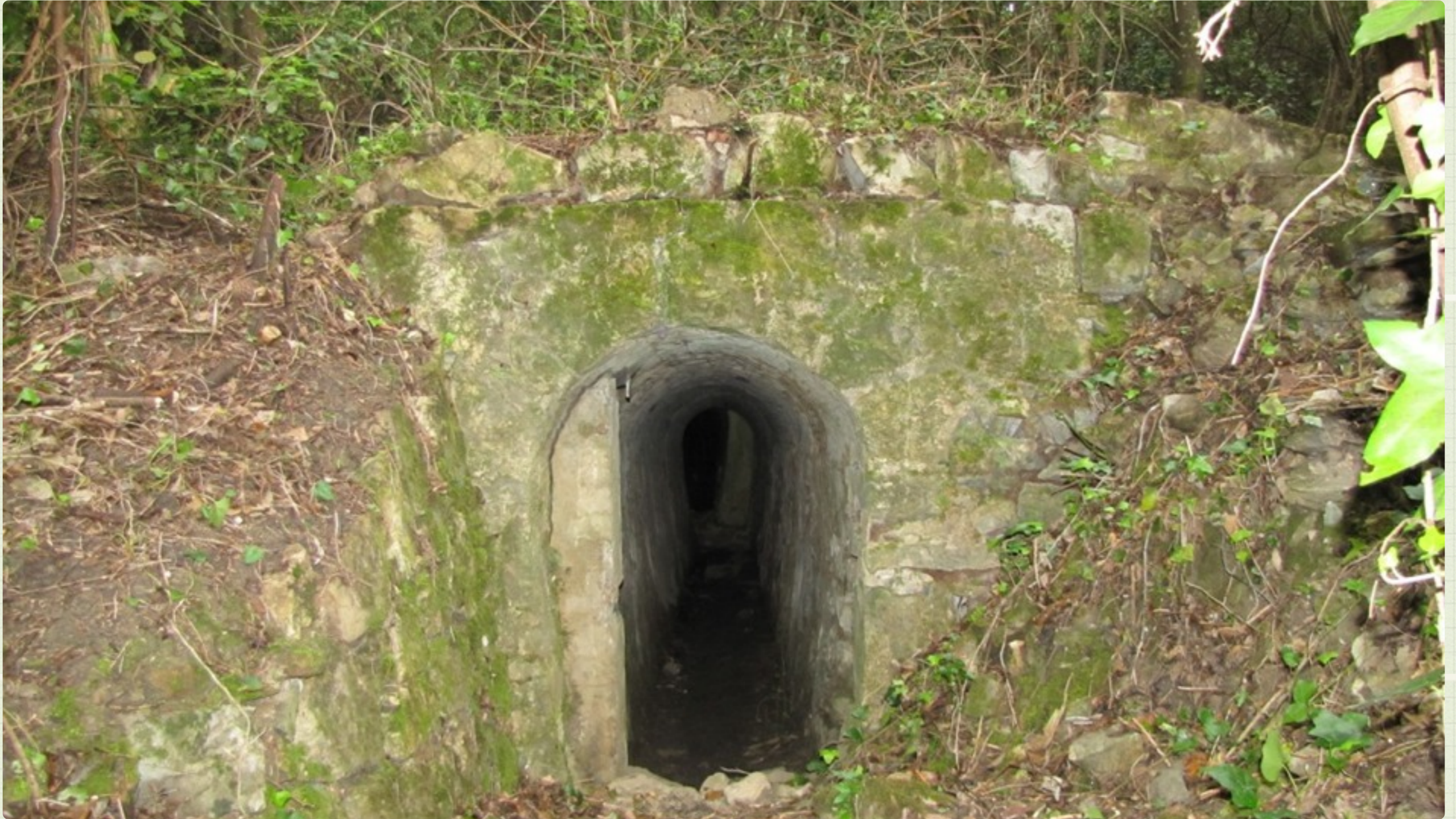
Ingresso alla sorgente
